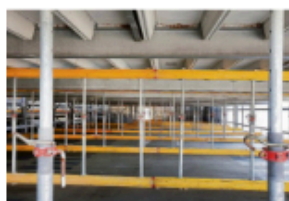
Das marode Parkhaus am Bahnhof Kamen ist auf zwei Parkdecks nun weitgehend abgeräumt worden. Das errichtete Fachwerk ist zu prüfen, wie stark das Gebäude geschädigt ist.
